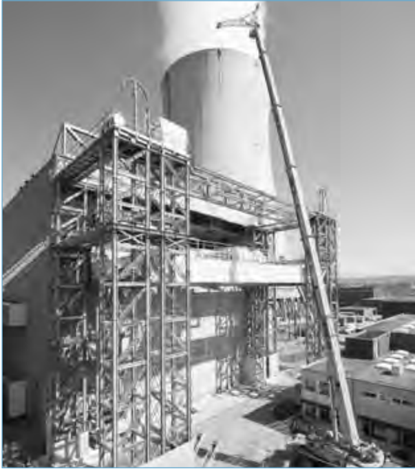
Einbau des neuen Maschinenhauskrans im September 2012.
