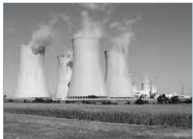
Das Kernkraftwerk Dukovany umfasst vier WWER-440/V213-Reaktoren, die 1985–1987 den Betrieb aufnahmen und seither nachgerüstet worden sind.
