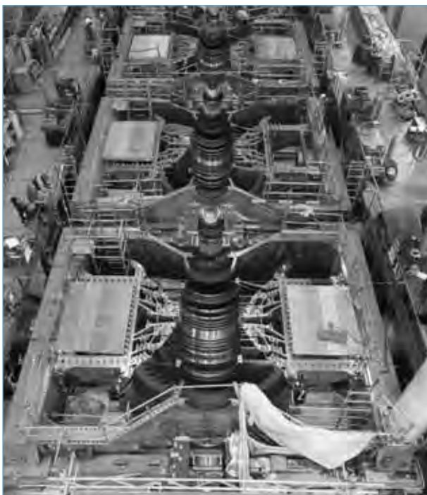
Offene Niederdruckturbinen während der Revision im KKG.
