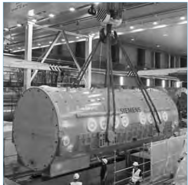
Der neue Stator wird platziert.
